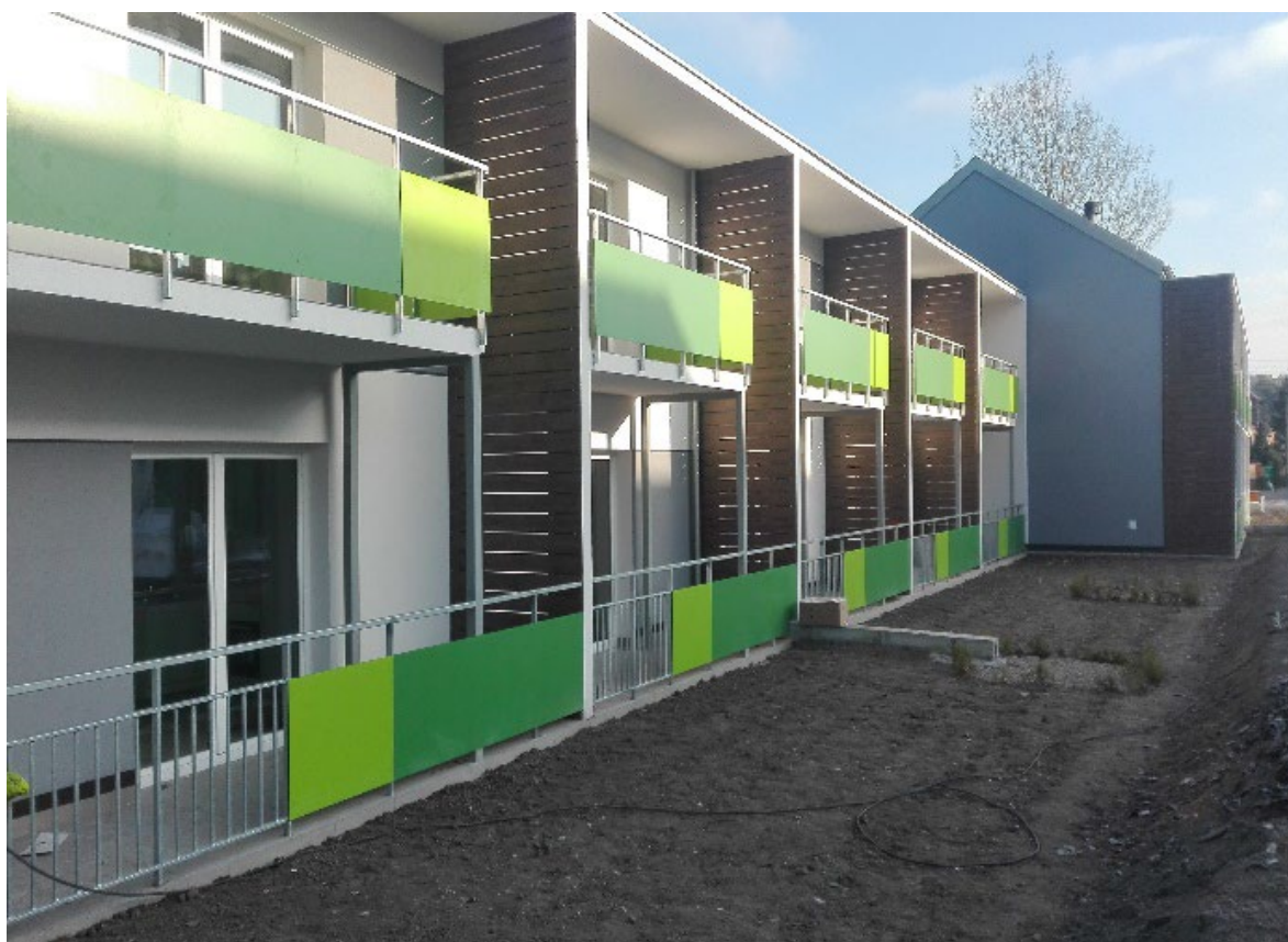
Fot.10. Jeden z budynków komunalnych wykonanych w ramach inwestycji (źródło: piastow.pl)
