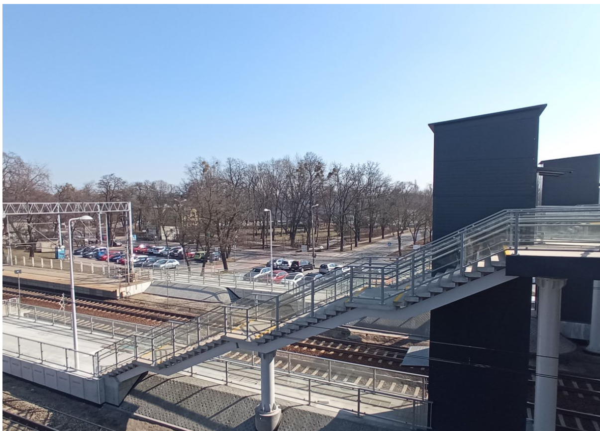
Fot. 14. ul. Dworcowa po remoncie (źródło: piastow.pl)
