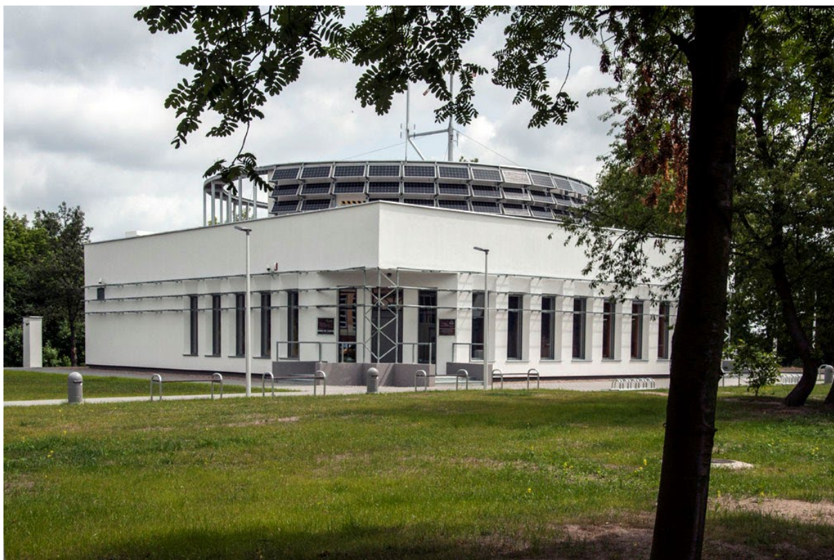
Fot. 21. Budynek Centrum Demonstracyjnego OZE (źródło: www.bydgoszcz.pl )
